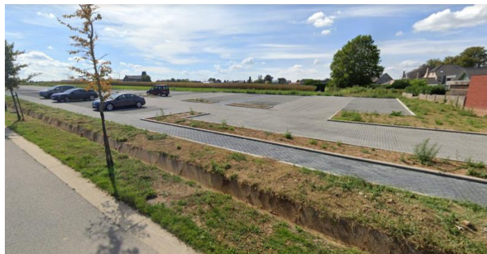
Figuur 110: parking in Vroenhoven, voorzien van waterdoorlatende verharding en groenvakken
